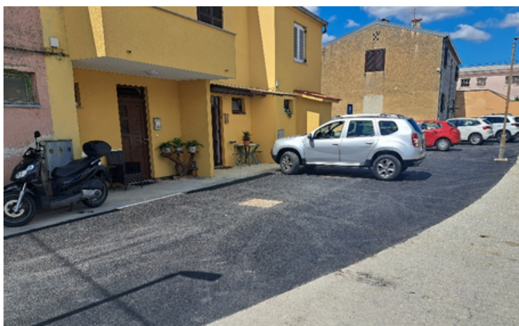
Proširena asfaltna površina
