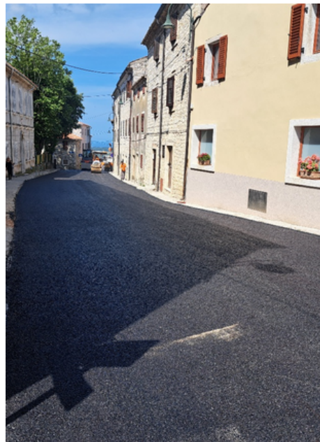
Novi sloj asfalta
