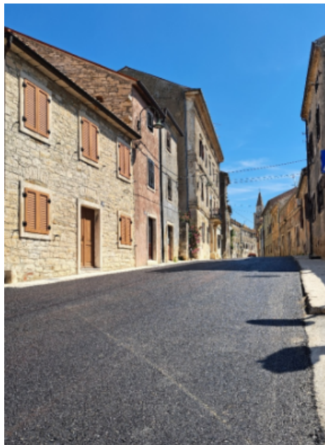
Novi sloj asfalta
