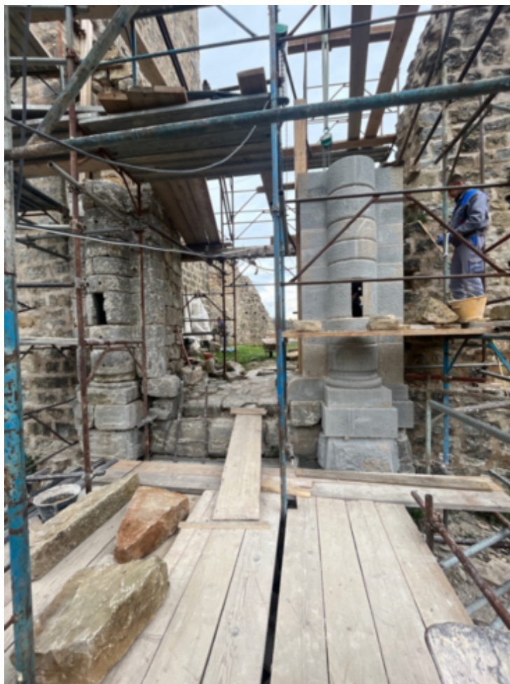
Rekonstrukcija glavnog portala
