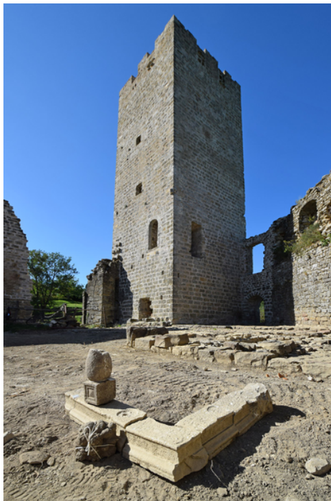
Rekonstrukcija glavnog portala
