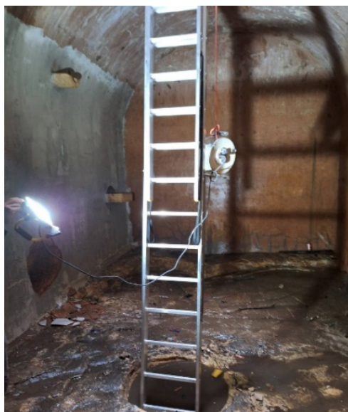
Sanacija unutrašnjeg djela
