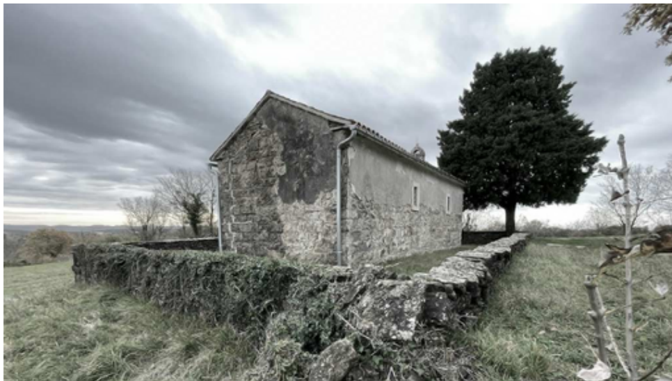
Rekonstrukcija glavnog portala
