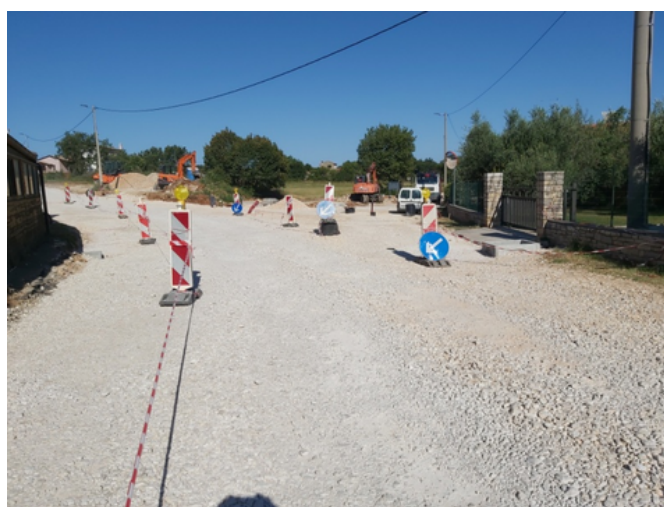
Slika 32: Radovi na rotoru
