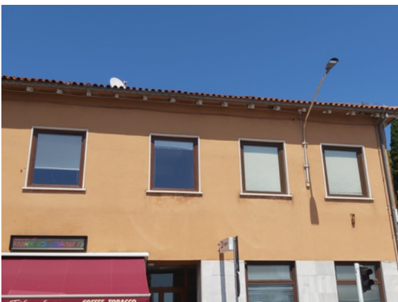
Slika 6: LAN mreža u zgradi POU
